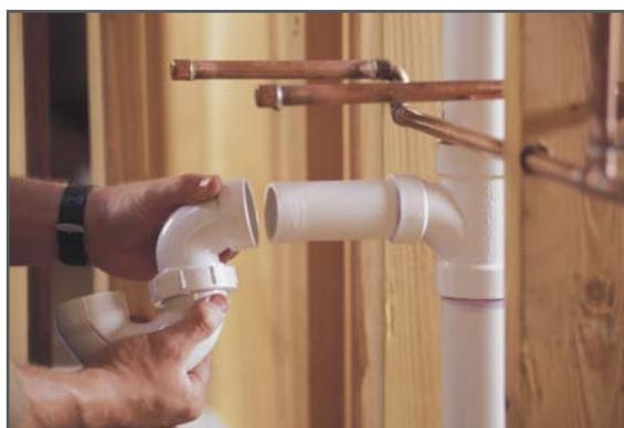
Le collage ne peut se faire qu'à froid, il est interdit de chauffer les tubes et raccords en PVC. Ces derniers doivent en plus avoir un repère de montage pour éviter les erreurs, il est possible de les faire au feutre.
