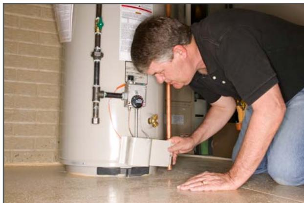
De plus, il est recommandé de vidanger chaque mois un ou deux seaux pour limiter la sédimentation et/ou réduire les bruits du chauffe-eau. Qu'il soit électrique ou à gaz, la vidange s'effectue de manière identique.
