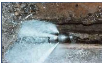
La tête de curage est l'outil de travail permettant la mise en œuvre de l'eau sous pression, en particulier pour les tâches de nettoyage, décapage, curage de canalisations ;
